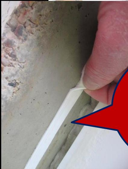
Der Schaden: Wir erkennen, dass der Beton die Unternäßung bei Starkregen während der Bauzeit verursacht hat. Diese Bänder sind während der Bauzeit zu schützen!!!!
